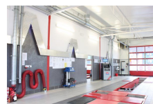
STACJA KONTROLI POJAZDÓW
