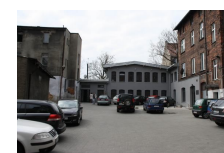
PRZEBUDOWA SZWALNI NA BIURA
